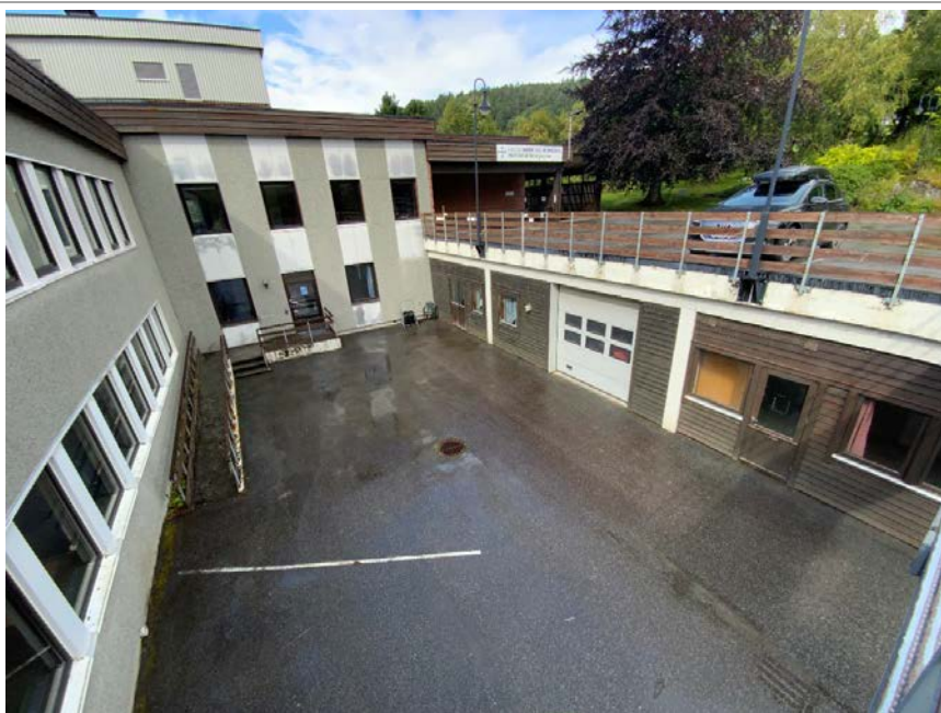
2. Oversikt fra gangbru.
