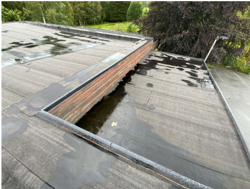
17. Tak over inngangsparti.
