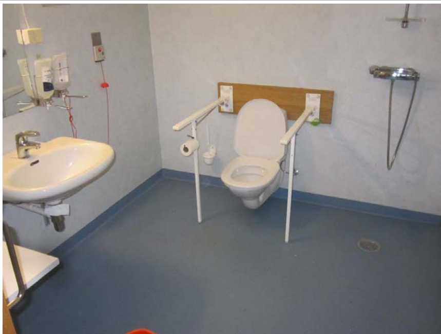
82. Baderom tilhørende pasientrom. Renovert ca. år 2000, med våtromsbelegg på vegger og gulv.
