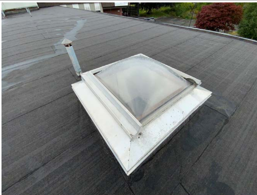
28. Tak over kontor- og pasientromfløy: Takvindu
