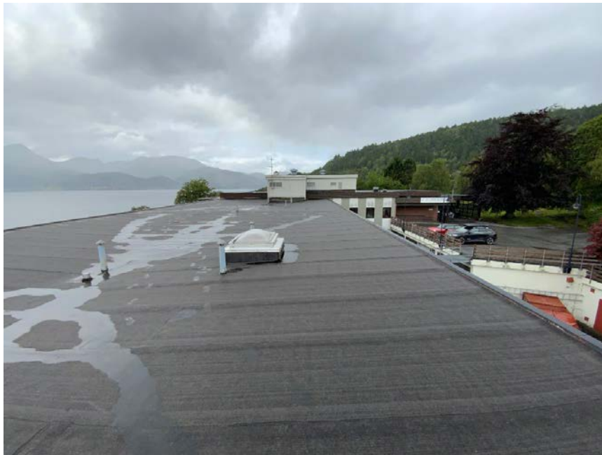
27. Tak over kontor- og pasientromfløy.
