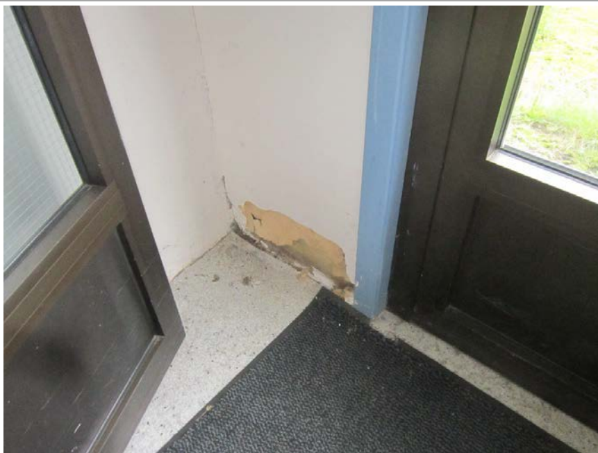
65. Korridor v. ytterdør, Ref. bilde 60.
