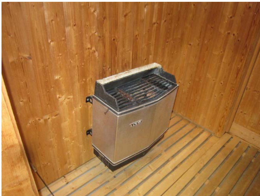
45. Badstue mellom garderobe.
