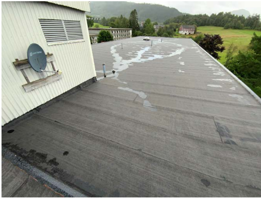
23. Tak over kontor- og pasientromfløy
