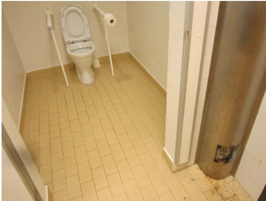
43. WC og avløpsrør i garderobe.
