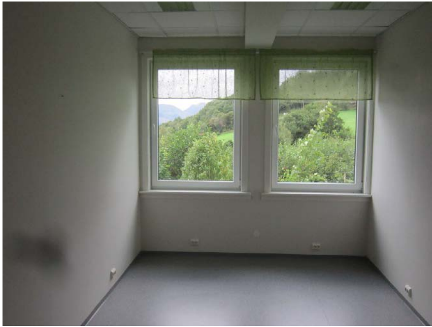
95. To kontor tilknyttet ergoterapeutrom. Gulvbelegg i god stand, PVC-vinduer fra 2009.
