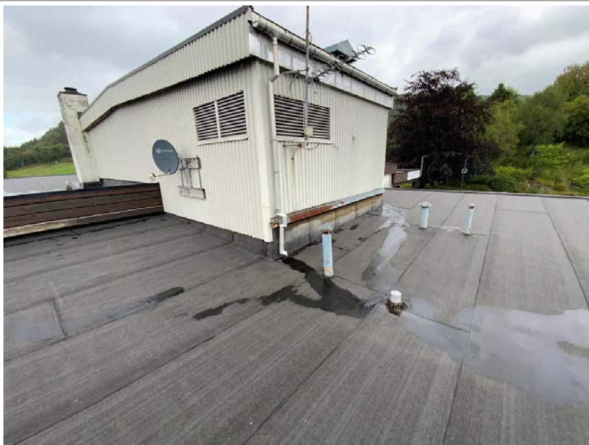
24. Tak over kontor- og pasientromfløy.
