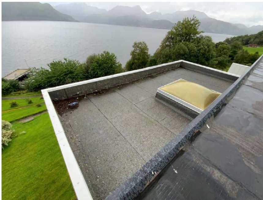
29. Tak over røykerom.
