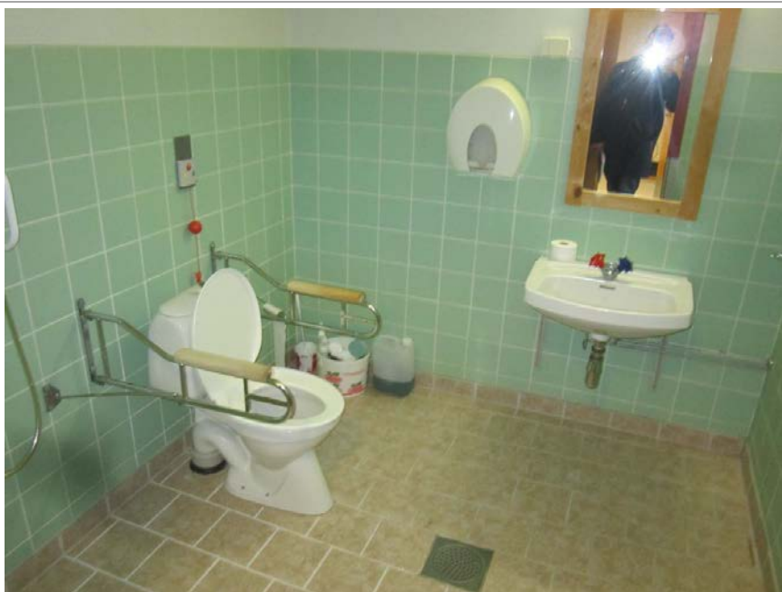
66. Rom 008, delvis renovert, flis på gulv.
