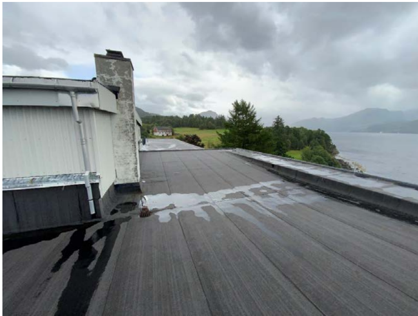
21. Slitt murmaling på pipe.
