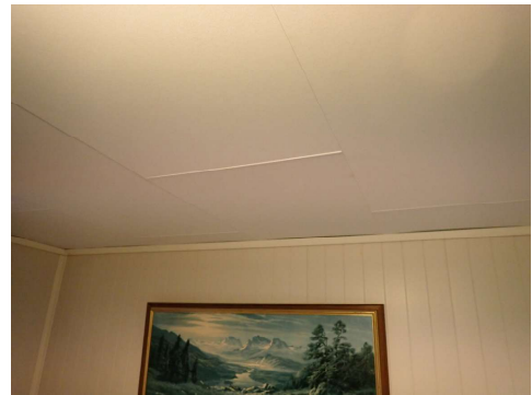
Plateskjøte himling soverom sørvest u.etg. ujevne - tydelig at her er/har vært forhøyet luftfuktighet i rommet
