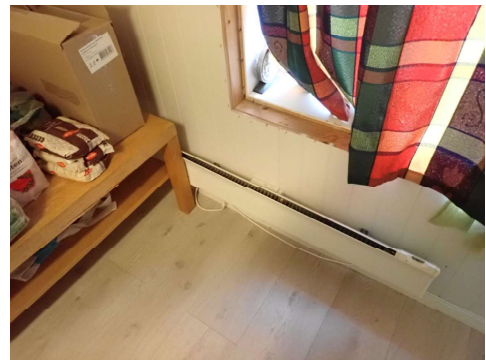
Ikke ferdigstilt utføring vindu/listverk soverom sørvest u.etg.
