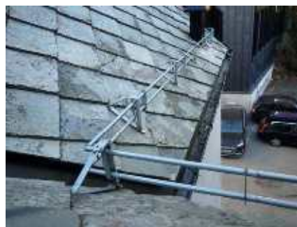
Snøfangere mot bakgård
