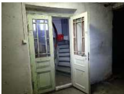
Dør fra kjeller til trapperom
