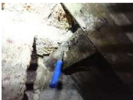
Bjelke mot pipe - treverk hardt - testet med kniv.
