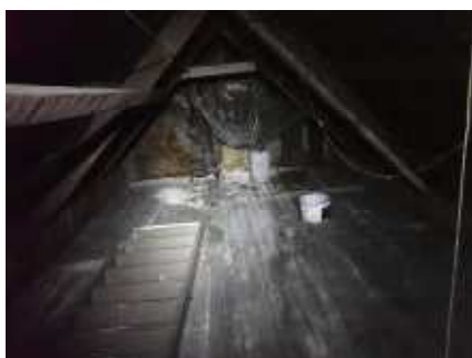
Oversikt loftsrom fra lukeområde mot nord.
