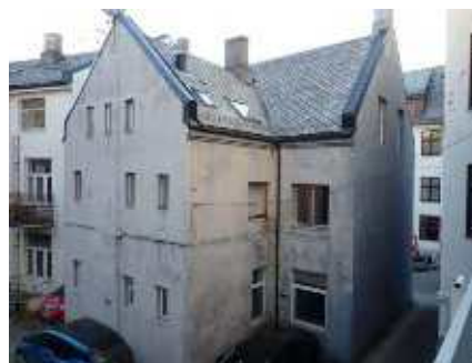
Sikre at vann fra taknedløp føres i tette rør bort fra bygget.
