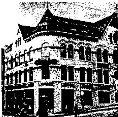
Kongens gate 18. Revet og gjenoppbygget 1975.
