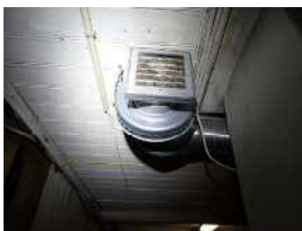
Trepanel i deler av himling i kjeller - montert ventilasjonskanaler og avtrekksvifte
