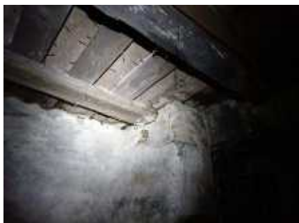
Bjelkelag over kjeller
