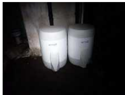
Varmtvannstanker 1A og 1B plassert i
