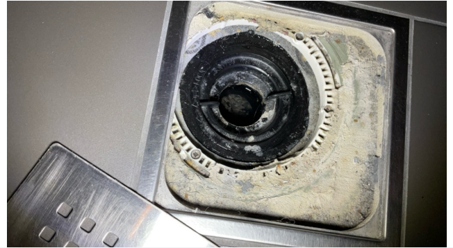
UNDERETASJE > BAD 7,8 M 2
