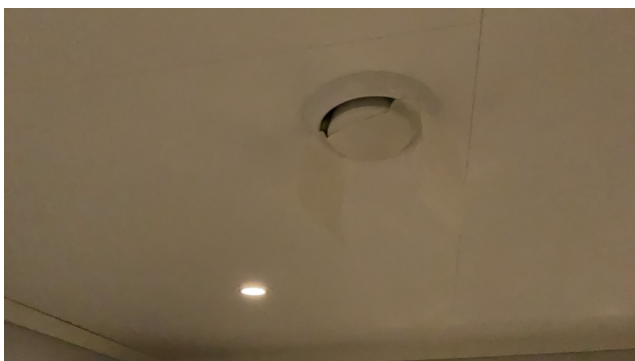
UNDERETASJE > BAD 7,8 M 2
