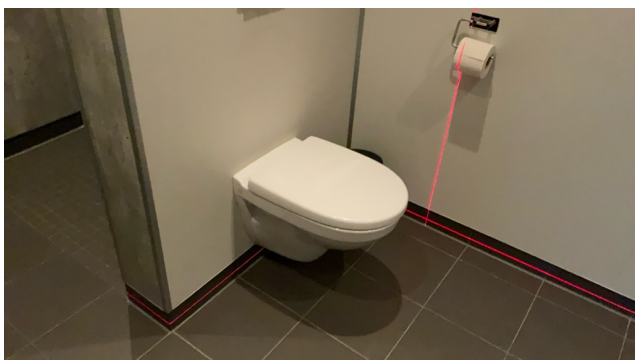
UNDERETASJE > BAD 7,8 M 2
