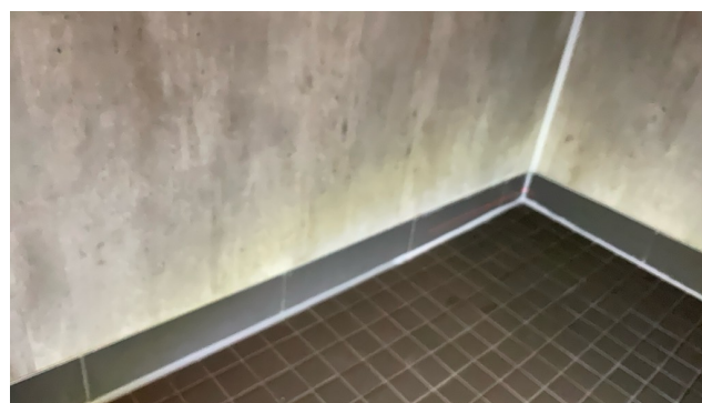
UNDERETASJE > BAD 7,8 M 2
