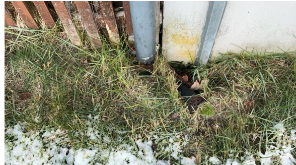
Nedløpsrør avsluttet over terreng.
