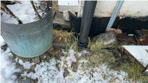
Tilkobling i grunn på baksiden (tilbygget).
