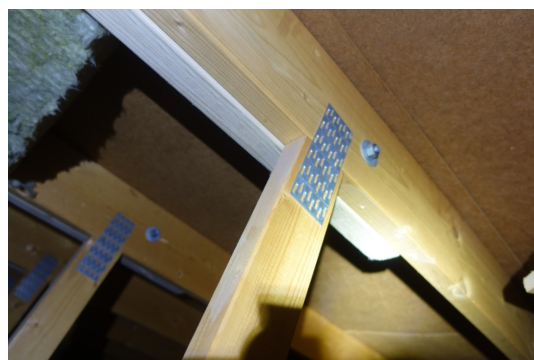
Bildet viser påmonterte lasker på takstol i forbindelse med ombyggingen av takkonstruksjon.
