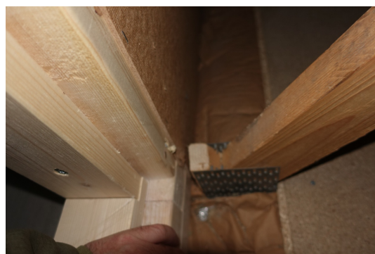
Bildet viser hvor deler av takkonstruksjonen er fjernet ved spikerplater i forbindelse med ombyggingen av konstruksjonen.
