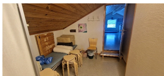
Skrå himling 2.etg. (gang)
