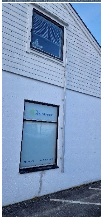
Mot øst. røminingsstige.
