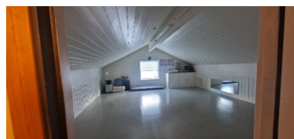
Skrå himling 2.etg. (treningshall). Malt, inkl. brystningspanel.
