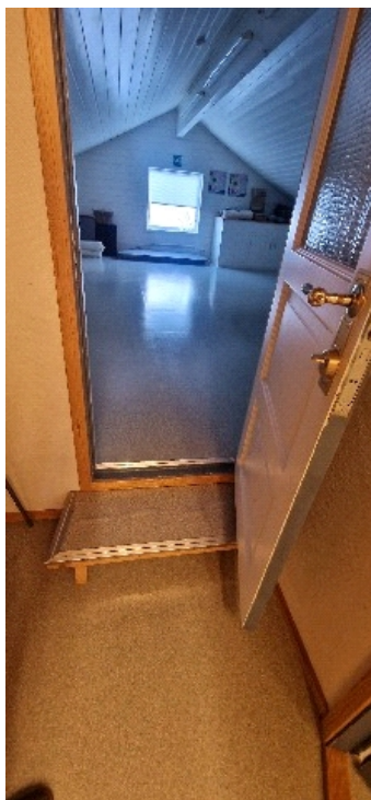
Gang 2.etg. med trinnløsning til treningshall
