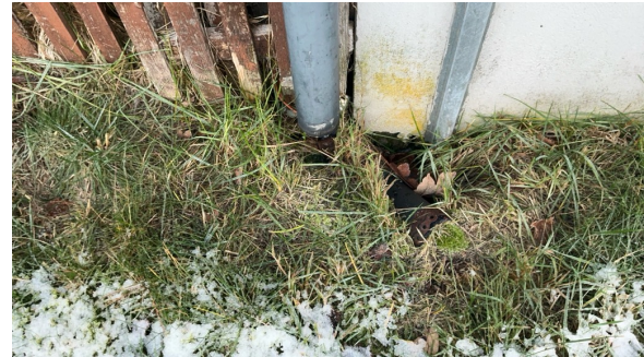
Nedløpsrør avsluttet over terreng.
