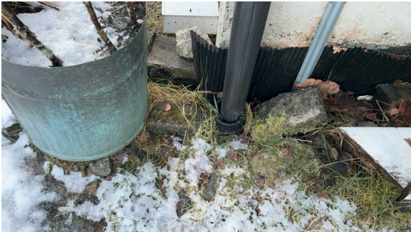
Tilkobling i grunn på baksiden (tilbygget).
