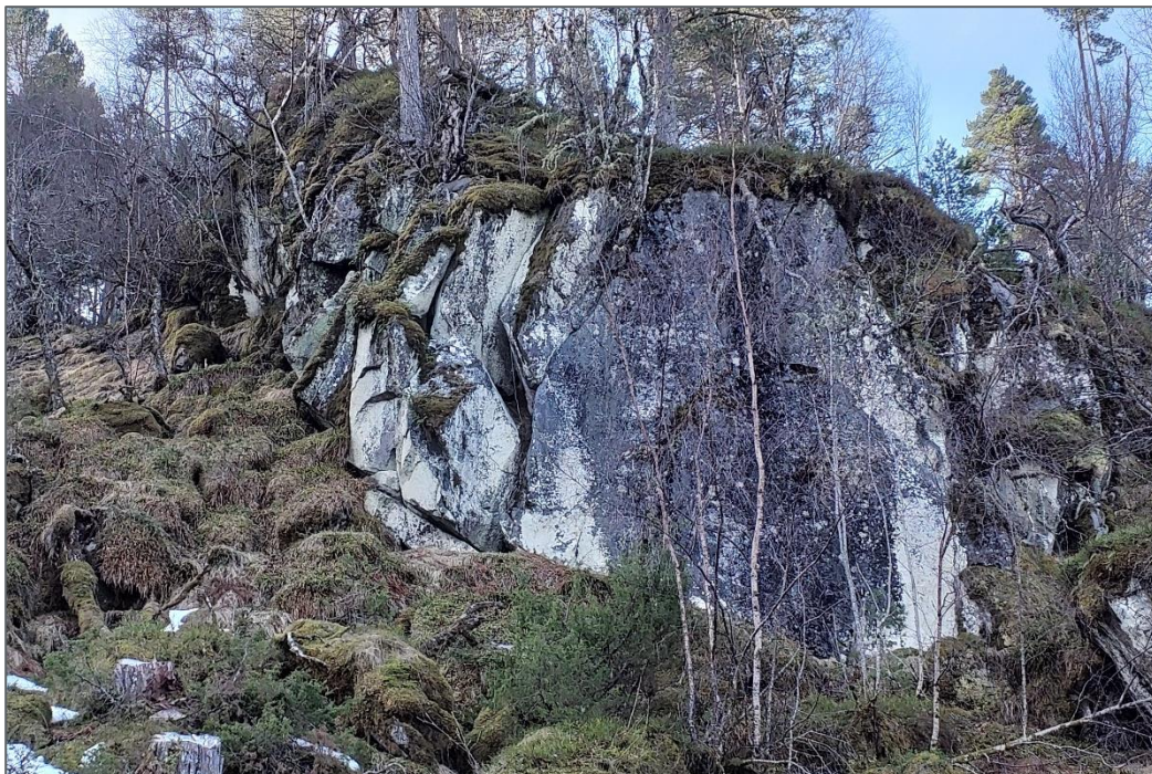
Figur 13: Naturlig bergskrent sørøst i kartleggingsområdet med sprekkeavløste blokker som bør bergsikres.
