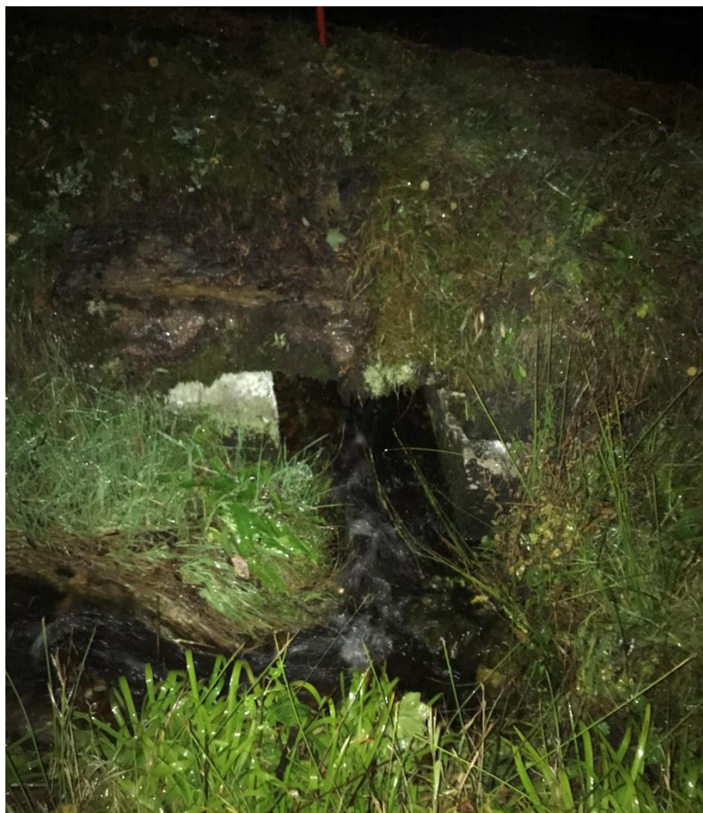
Figur 5: Inntak rektangulær stikkrenne.
