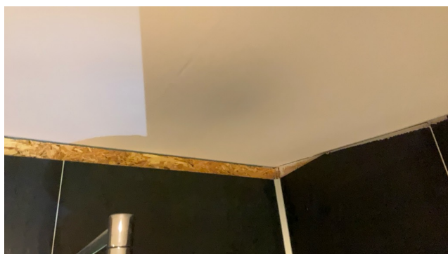
1ETASJE > BAD TILBYGG ØST
