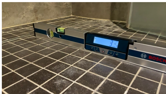
1ETASJE > BAD TILBYGG ØST
