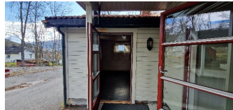
Inngang til vognrom tilbygget mot øst.
