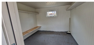
Innvendig med belegg og malte flater
