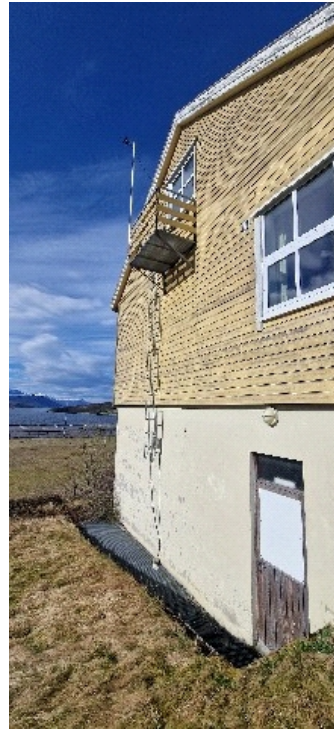
Mot sørøst. Rømningsvei fra loft. Inngang u.etg.
