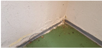
Fuktinntrekk grunnmur
