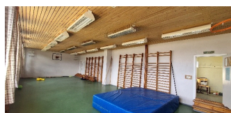
Gymsal med tilfarergulv og gulvbelegg.
