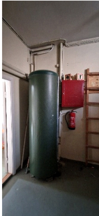
V.v.bereder i u.etg
