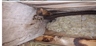
Isolasjon og luftesjikt i takkonstruksjon
