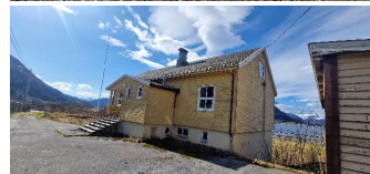
Tak, pipe, snøfangere og nedløp.
