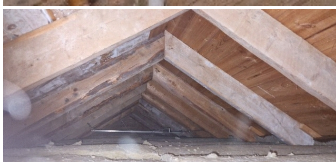
Spissloft med adkomst gjennom loftsluke
