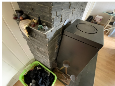
Liten avstand til brannmur mellom fra ovn.
