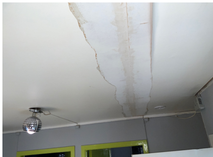
Skade på malerpapp
