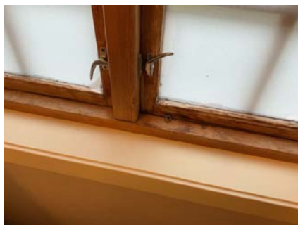
Bad andre etasje
