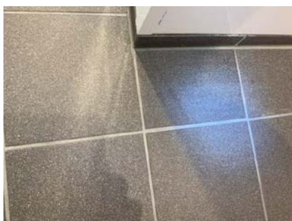
Mangler ved fuge (meldt utbedra av eier) og avvik i bredde/mellom fliser
