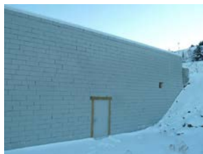
Mot vest fasade malt på forskalingsflokk. Gesimsbeslag.
