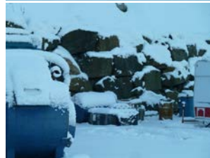
Natursteinsmur for veiadkomst til fremtidig 2.etg. over bygg B.
