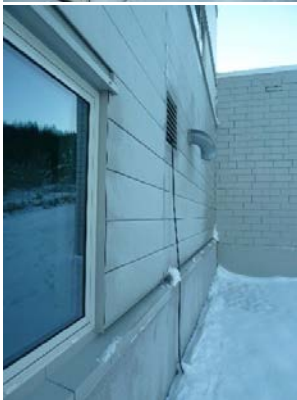
Fasadekledning mot vest. Metallkledning over sokkel kledt med steni fasade-plater
