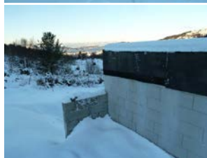
Mot sør forskalingsblokk og tilbakefylt grunnmur. Taktekking over gesims.
