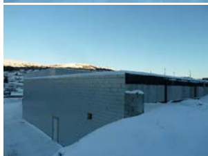
Mot sør og vest er malt på forskalingsblokk.
