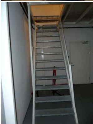
Metalltrapp til mesanin i verkstedhall
