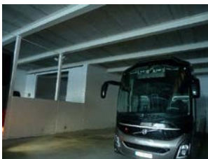
Gulv med grusdekke. Innside yttervegger i betong forskalingsblokk, malt overflate. Himling er ubehandlet underside HD-elementer opplagt på bærende stålbejler og -søyler.
