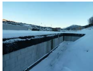
HS-elementer opplagt på stålbejler over yttervegg og forsterket opplegg mot bygg A.
