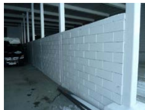
Skillevegg mellom lagerhaller. Bærende stålsøyler for takkonstruksjon
