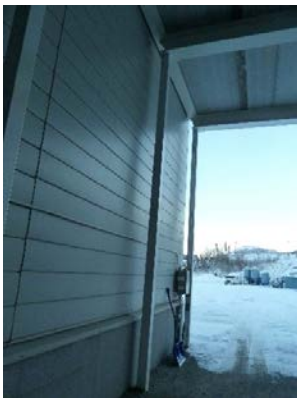
HS-elementer opplagt på stålbejler over yttervegg og forsterket opplegg mot bygg A.
