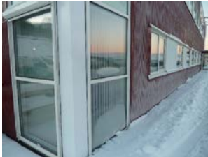
Påkostet fasade med Møre Roal impregneret bordkledning.
