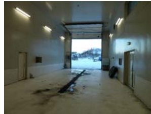
Vaskehall. Vannbestandige flater
