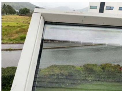
Slitasje/avflassing soverom mot svalgang.
