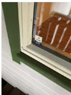
Slitasje/avflassing soverom mot svalgang.
